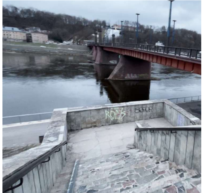
9. Nuo Karaliaus Mindaugo pr. laiptai link pėsčiųjų tunelio žiūrint Pietų kryptimi link krantinės. Laiptai iš granito dangos. Atraminių sienelių apdaila pažeistos, ištrupėjusios, atraminės sienutės sienos su įtrūkimais ir kitais pažeidimais. Neužtikrinimas žmonių su negalia tinkamas nusileidimas iki požeminės perėjos. Neužtikrinamas tinkamas apšvietimas saugiam patekimui į požeminę pėsčiųjų perėją.
